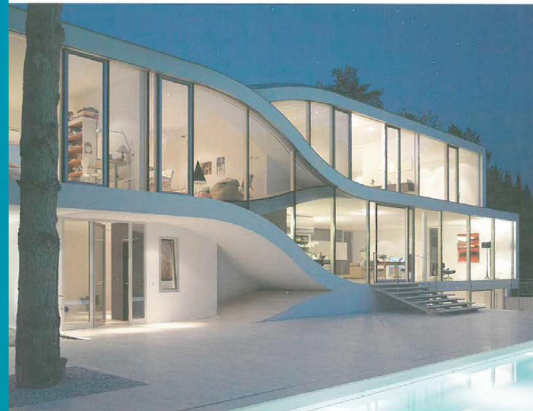
Aus dem Aufbau einer tragenden und kontinuierlichen Deckenstruktur ergeben sich klare Linien.
